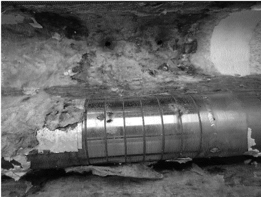
Тест В. Демонтаж после 21 цикла испытания В с материалом Prorox PS960 WR-Tech, содержащим ингибитор коррозии. Верхняя сторона пробных образцов без удаления отложений.
